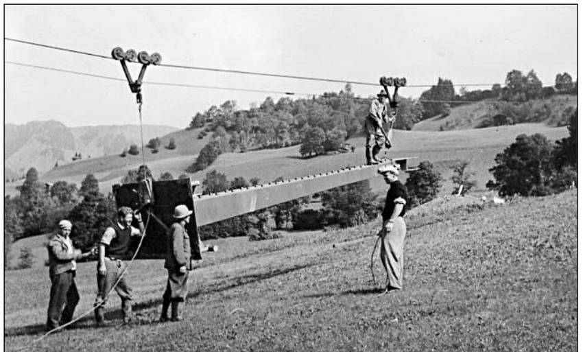
*Die alte Bahn diente auch als Transportmittel für die Stützen.*
