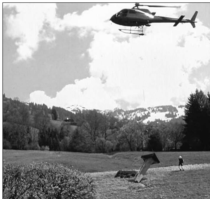
*Im Frühjahr 2008 wurde der Lift abmontiert und die Stützen mit Hubschraubereinsatz zur Talstation geflogen.*
