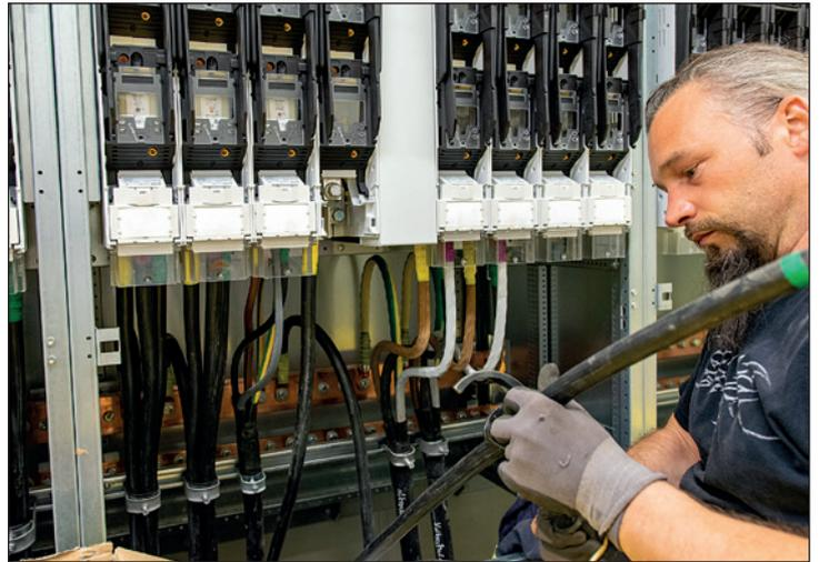
*In Reih und Glied liegen die neuen Kabel im Kabelschacht und werden mit einer akkubetriebenen Kabelschere abgelängt.*
