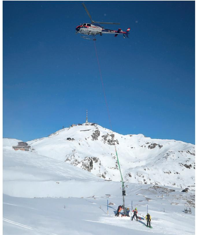
Die Schneemessstation wurde mit Hilfe des Landeshubschraubers am Hornköpflsee montiert. © Obermoser
